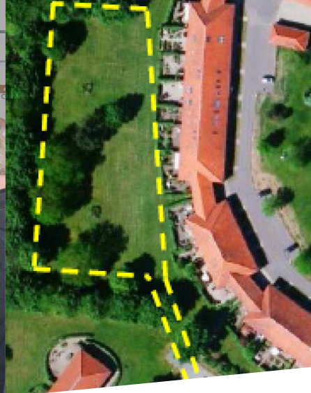
Ejerforeningen Nørrelundparken i Ribe, hvor placering af jordslangen til varmepumpen er vist.
